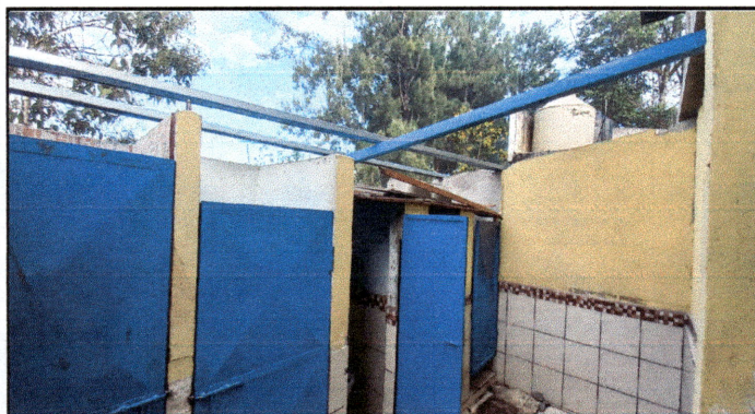
Foto 3: Módulo Baños, instalación de estructura metálica para soporte de lámina troquelada.
