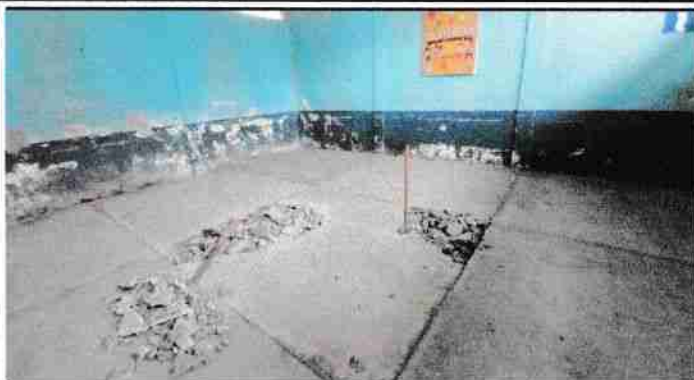
Foto 7: Aula 2 del módulo 3. Se observa proceso de remoción de torta de concreto en mal estado.
