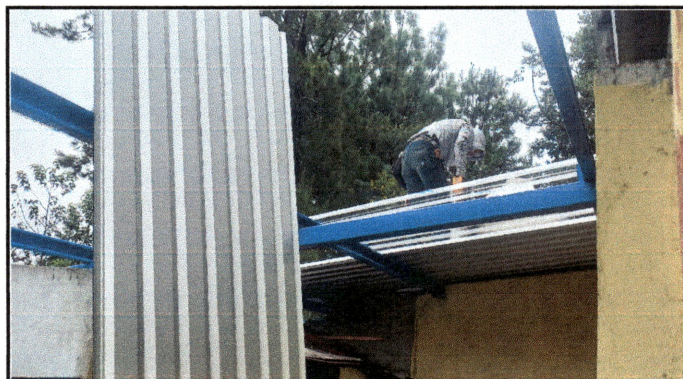
Foto 4: Módulo Baños, proceso de instalación de lámina troquelada.
