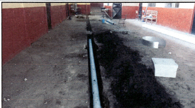
Foto 2: Se observa proceso de sustitución de tubería de aguas pluviales frente módulo 2.
