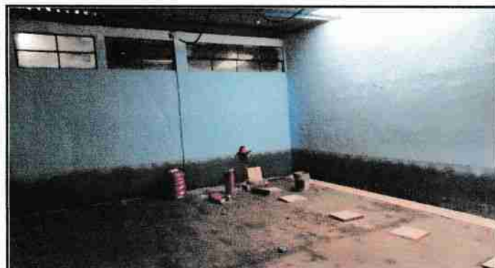
Foto 9: Aula 2 del módulo 4. Se observa proceso de instalación de piso cerámico.
