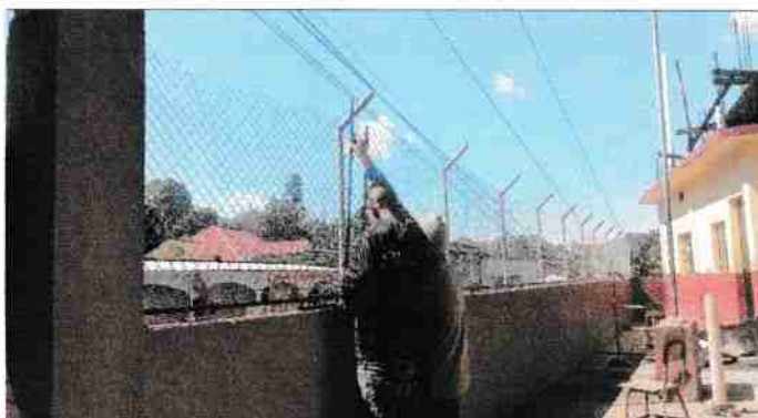
Foto 10: Muro perimetral. Proceso de sustitución de malla en muro perimetral.
