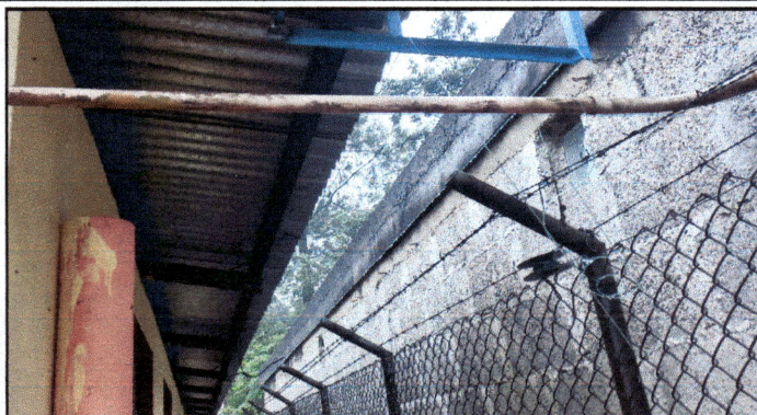
Foto 1: En módulo 1, se observa proceso de instalación de pescantes para canal de lámina lisa.
