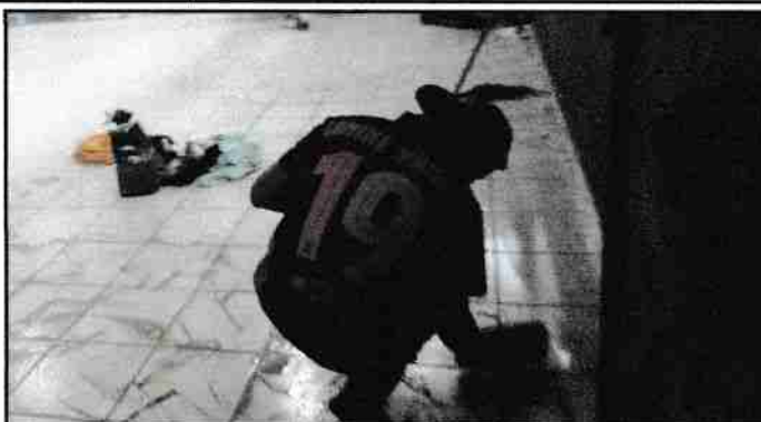
Foto 8: Aula 1 del módulo 4. Se observa proceso de instalación de piso cerámico.
